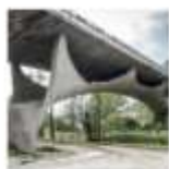
Ponte sul Fiume Savuto, Reggio Emilia
