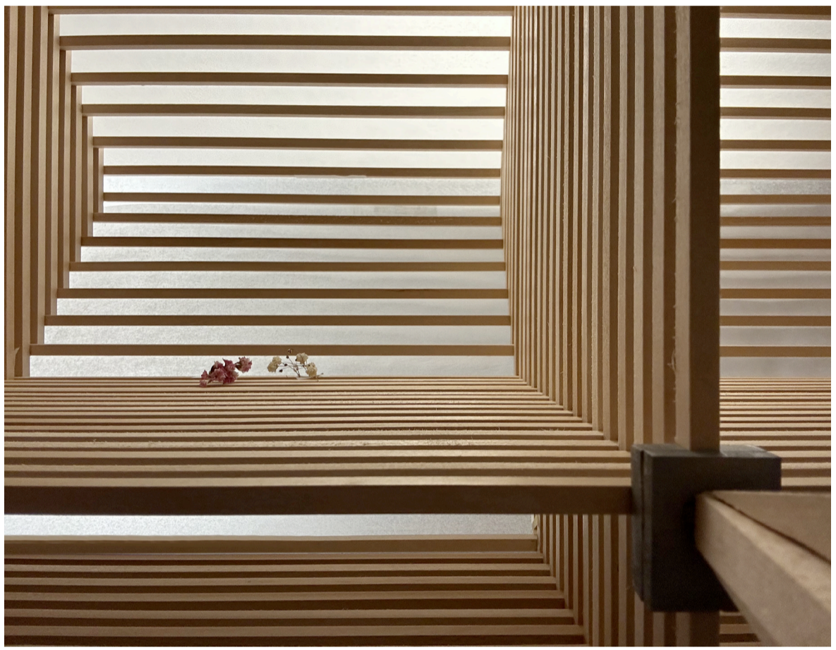
PARTICOLARE - VISTA DELLA STRUTTURA VERSO L'ALTO
